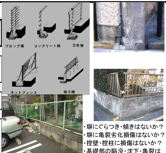
フェンスの損傷例
