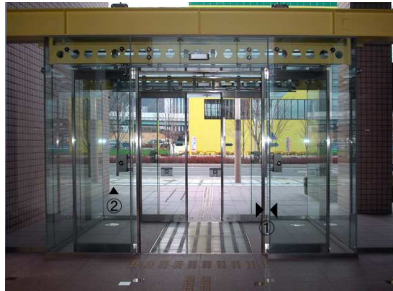
マットスイッチ式自動ドアの例
