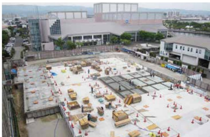
3月から、新庁舎を建てる場所に鉄筋コンクリートの土台(基礎)と、基礎と基礎をつなぐ梁をつくる工事を行った後、基礎と梁の上に新庁舎1階の床を鉄筋コンクリートでつくる工事を行ってきました。
