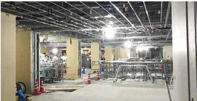
内装工事の状況(1階)
