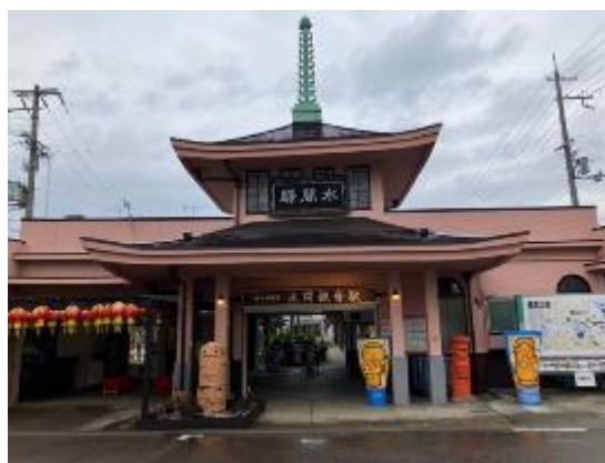
水間鉄道水間観音駅舎
