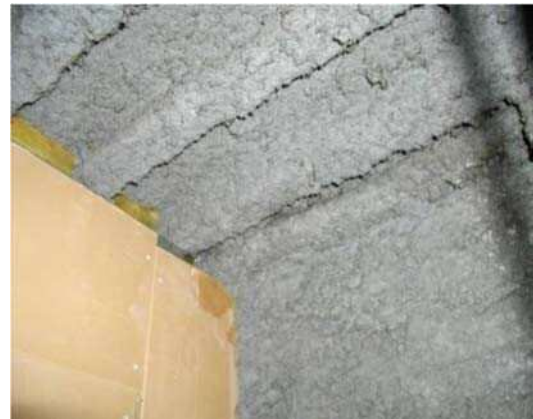
吹付アスベスト等が飛散し、暴露する可能性が高い
