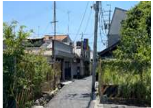
▲空き家が集積している南海貝塚駅東側
