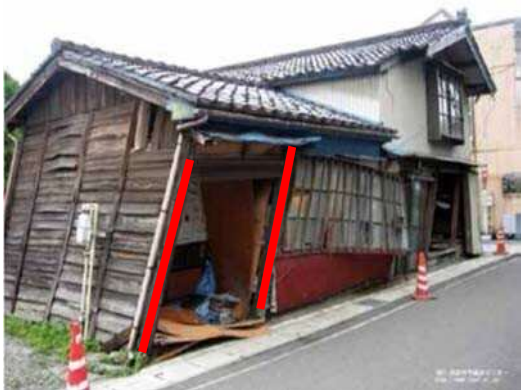
外壁が大きく傾斜しており、建具や窓枠がはずれ、原型を留めていない
