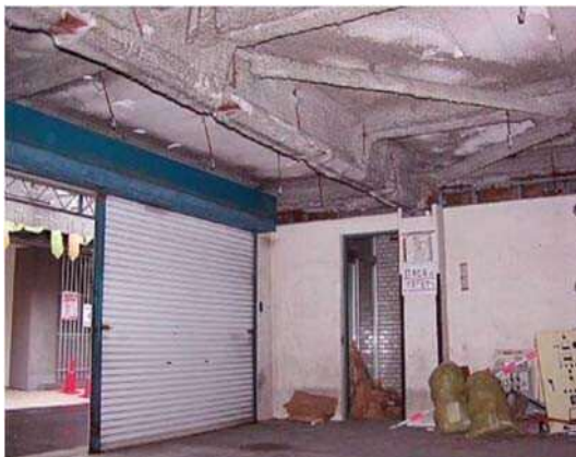
吹付アスベスト等が飛散し、暴露する可能性が高い
