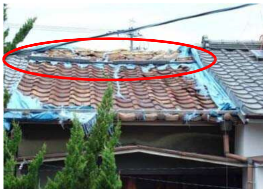
屋根ふき材に剥離、脱落が生じている
