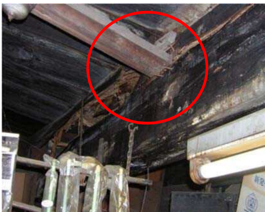
はりの破損、腐食などが発生している
