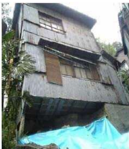
基礎が大きく欠損している (台風の影響による被害)
