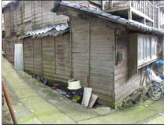
外壁が裸木造の例
