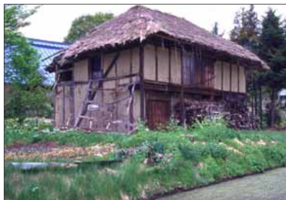
屋根材がワラの例
