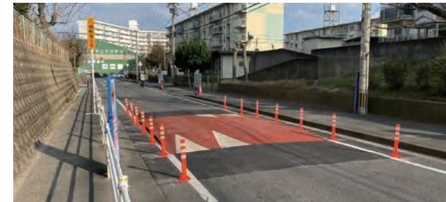
ハンプの試験設置の様子
