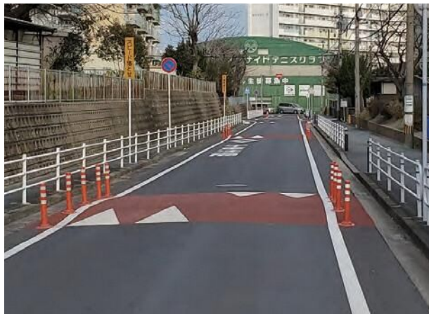
連続ハンプ設置状況（福岡県北九州市）
