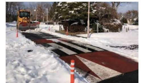
除雪作業の様子
