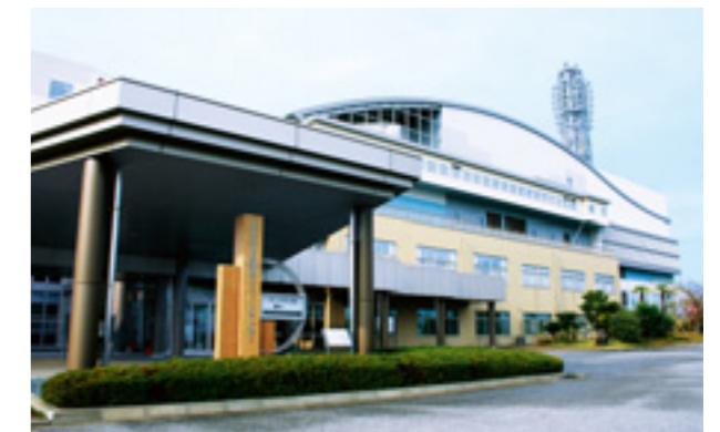
岸和田市貝塚市クリーンセンター
