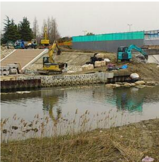
矢板上流部分から取りはずし (2012. 4. 13)
