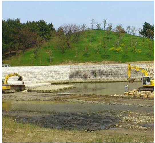
下流部分矢板取り外し (2012. 4. 19)
