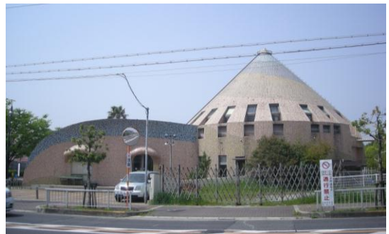
北側から見た自然遊学館の全景
