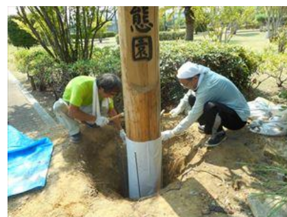
図6. 標柱を立てる
