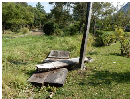
崩壊した案内板 (2018年9月5日)
