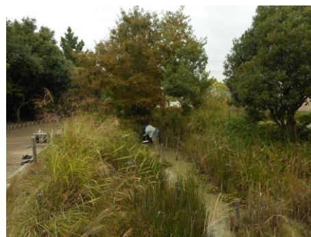
石積みを補修 (水位が低くなったトンボの池)
