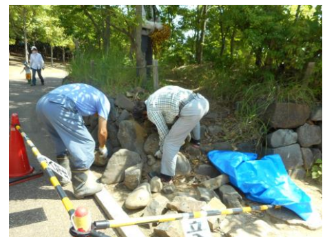
石積みの補修作業
