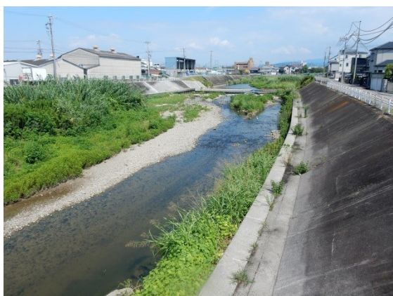
近木川下流（府道臨海線付近から上流を望む）
