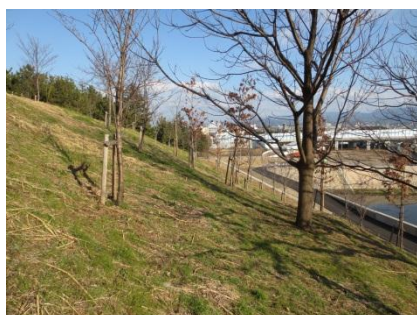
図 5-1. 汽水ワンド北側斜面 西側（下流側）から撮影
