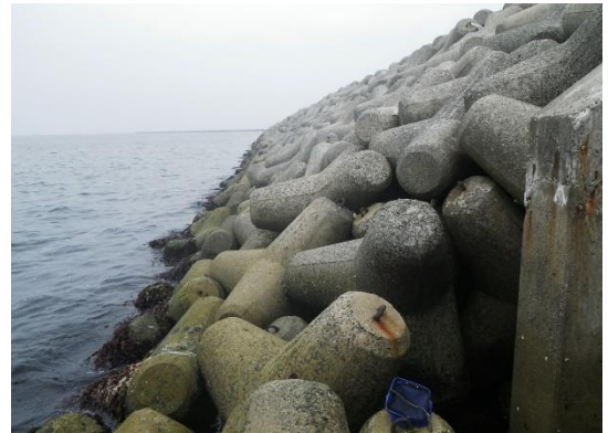
図 1. 人工島のテトラポット護岸
