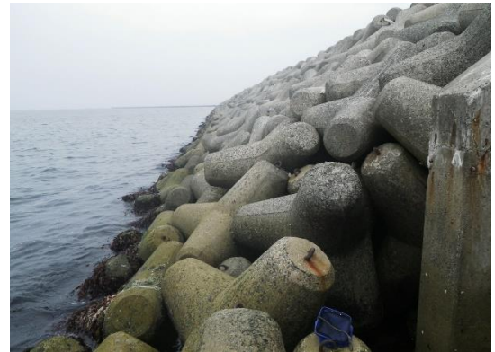
図1. 人工島のテトラポット護岸
