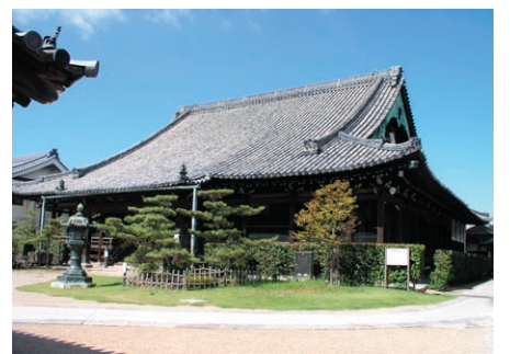
修理前の願泉寺境内のようす
