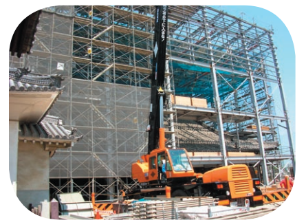
本堂の素屋根建設
