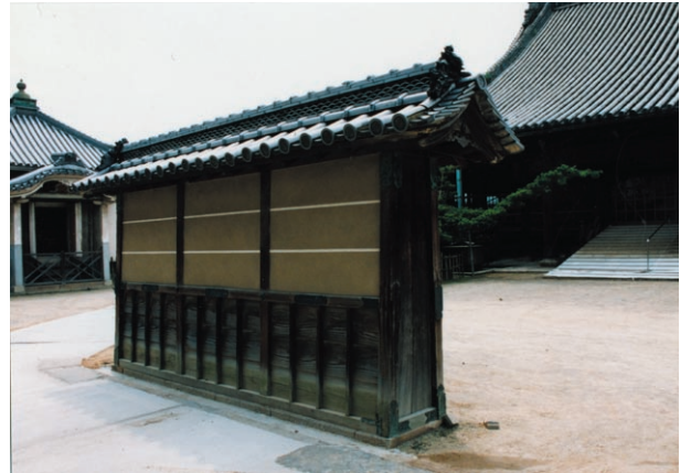
目隠塀(解体・収納前)
