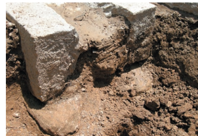
基礎石、根石の断面
