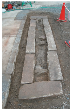
基礎石の状況
