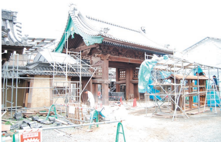
修理中の表門と目隠塀
