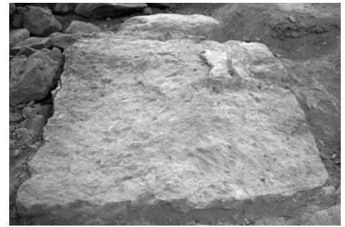
鐘楼北東隅の根石
