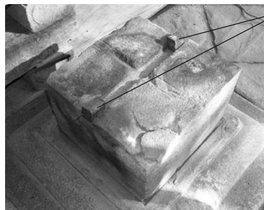
石材に彫られた溝
