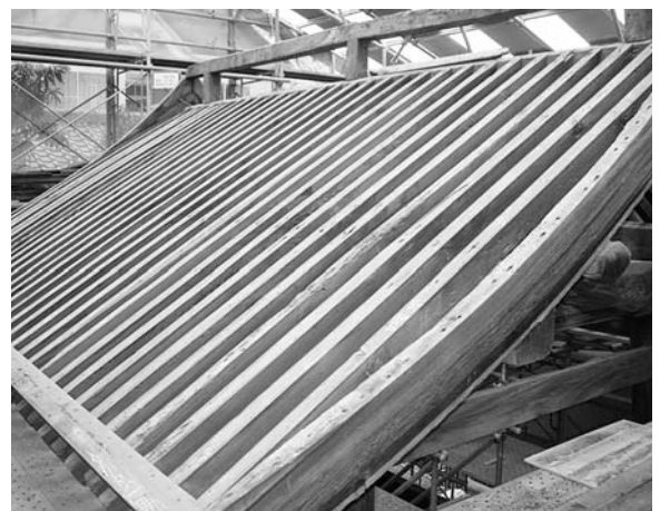
修理中の鐘楼（屋根部分）
