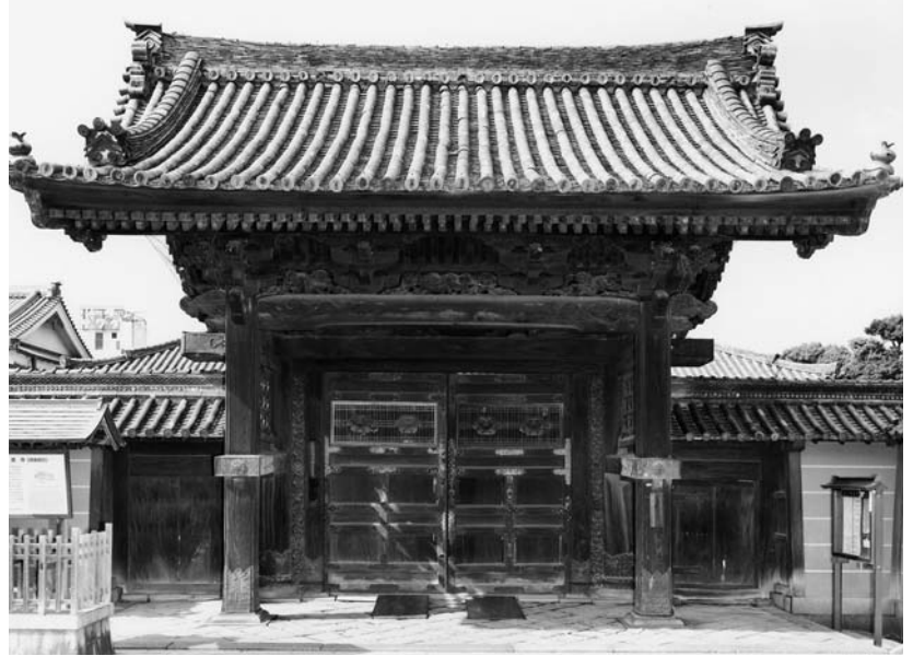
修理前の表門
