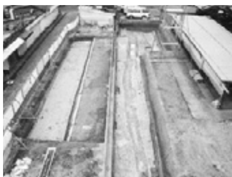
遺構検出の状況
