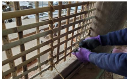
①壁の下地となる木舞の修理
