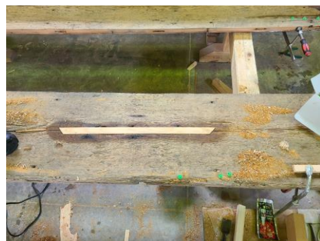
③外陣床板の補修 埋木作業
