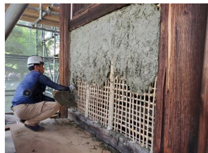
②壁の塗り直し 荒壁付
