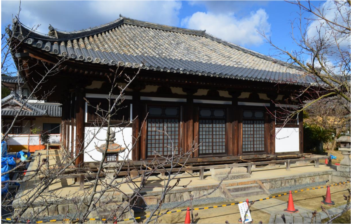
国宝孝恩寺観音堂の現況（令和4年1月撮影）
