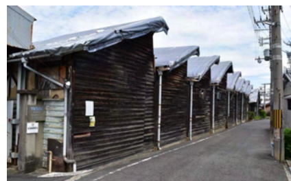
のこぎり屋根の工場外観
