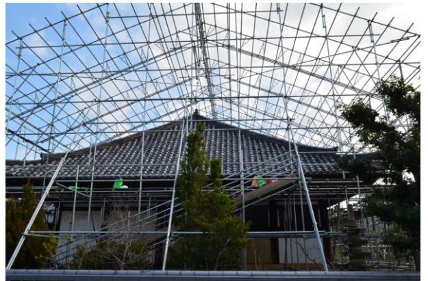
写真1 観音堂に設けられた足場と素屋根の骨組み（令和2年1月21日撮影）
