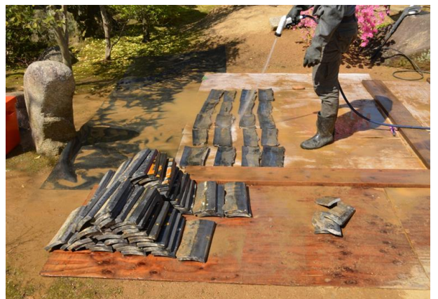
写真2 瓦にこびりついたコケや汚れをきれいに取り除く作業（令和2年3月23日撮影）
