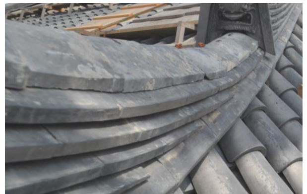
棟瓦の設置状況
