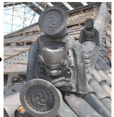
補修された鬼瓦と取り替えられた鳥衾瓦
