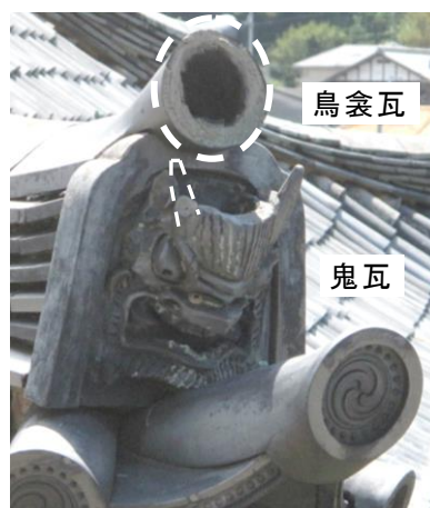
破損した鬼瓦と鳥衾瓦
