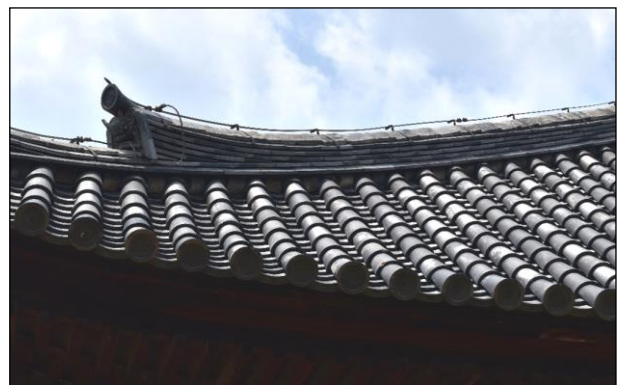
写真③ 修理後の屋根 その2
