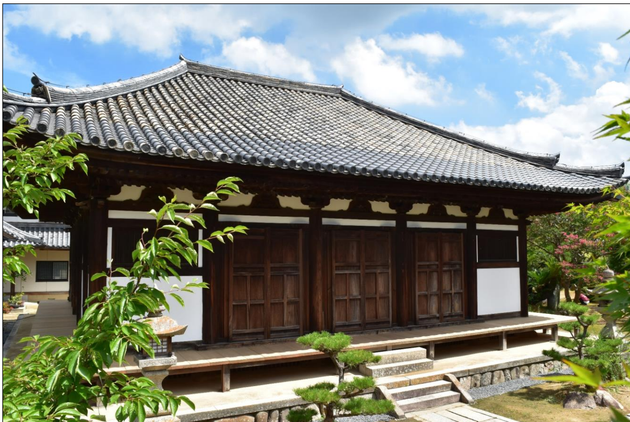
国宝孝恩寺観音堂の現況（令和4年7月撮影）
