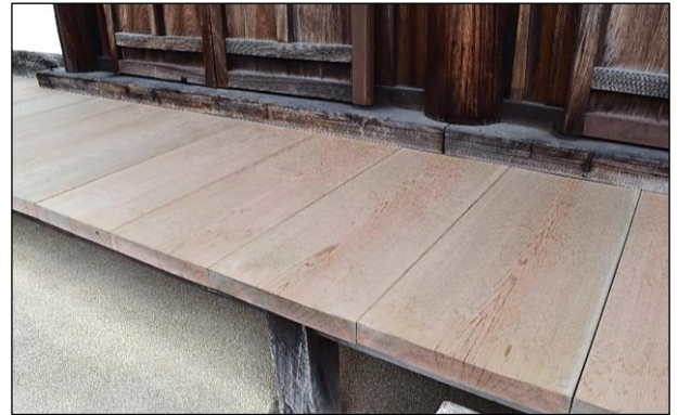
写真⑨ 修理後の棧唐戸と縁板
