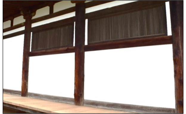
写真⑦ 修理後の漆喰壁 その2
