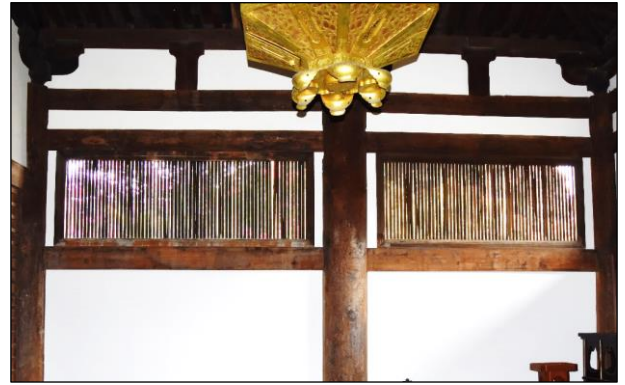
写真⑥ 修理後の漆喰壁 その1
