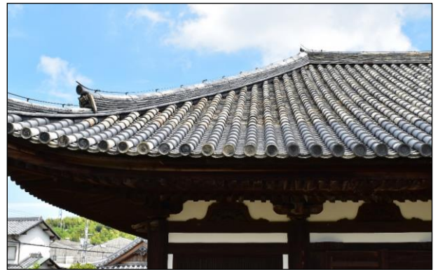
写真② 修理後の屋根 その1
