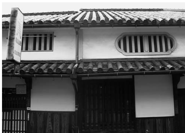
主屋（右）と隠居屋（左）とで異なる虫籠窓の形状
