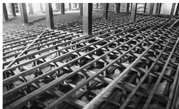
本堂床組（修理前）
