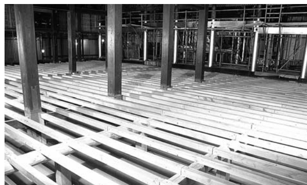
本堂床組（修理後）
