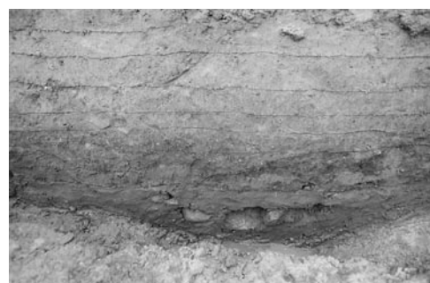
調査地1 溝（遺構）断面
