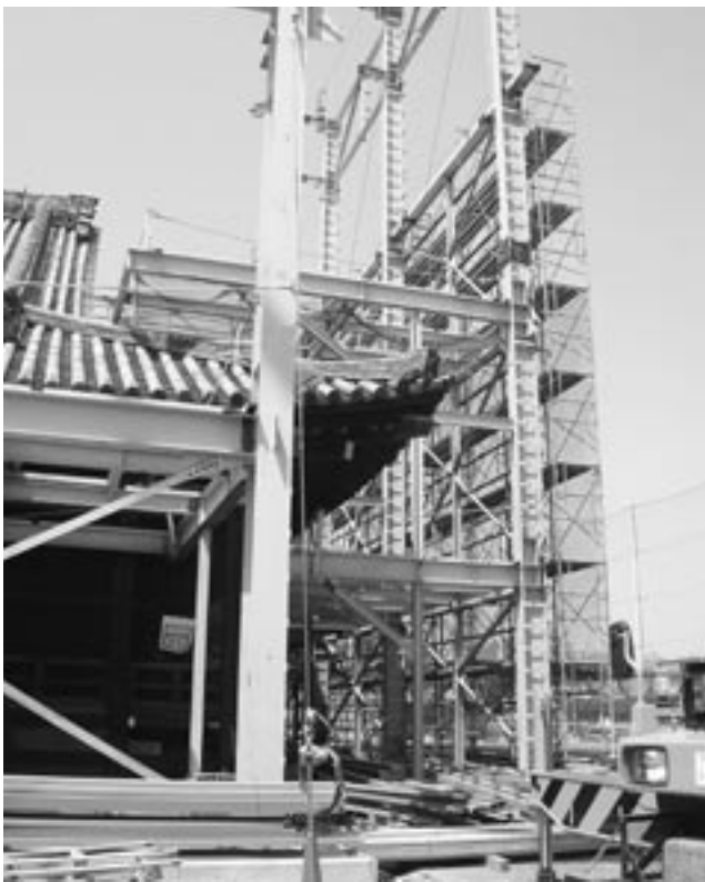
覆屋建設のようす
