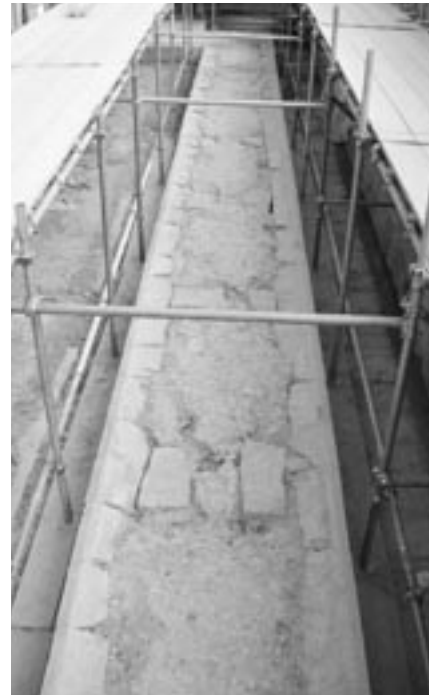
築地塀の基礎
