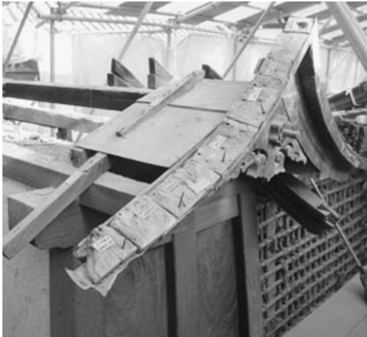
築地塀解体のようす
