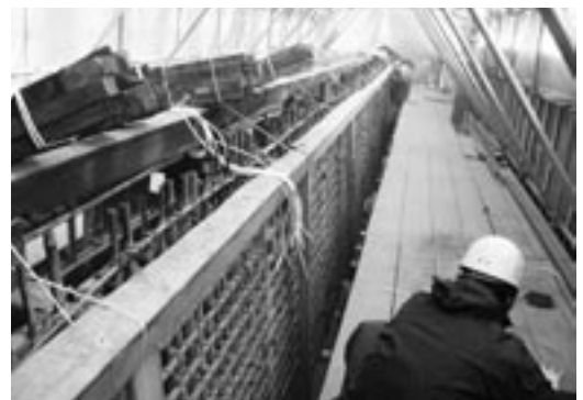
築地塀の解体修理（展示では木組を復元します）
