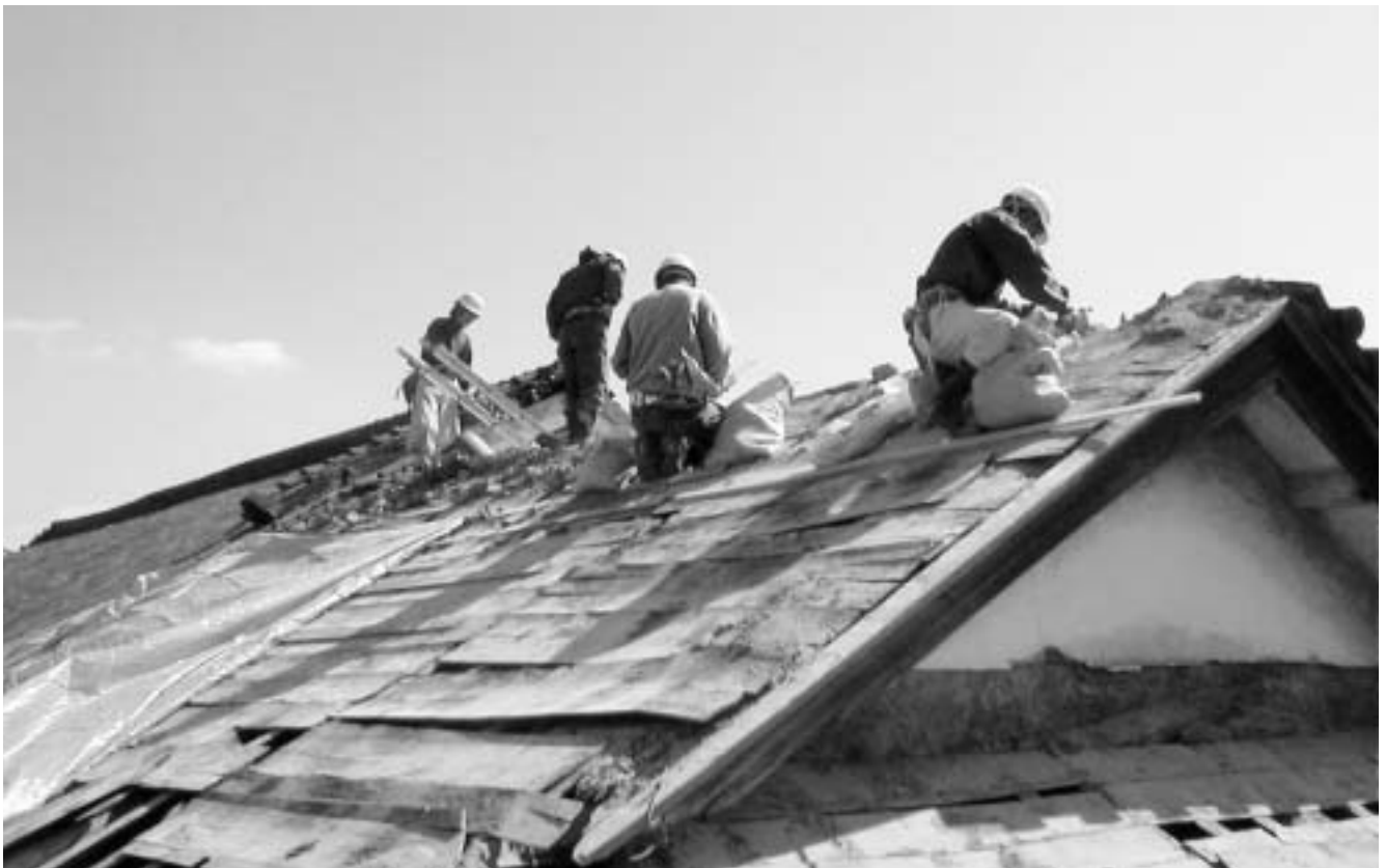
廣海家屋根瓦葺き替え工事風景
