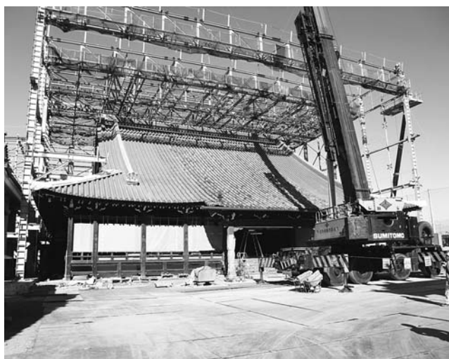
クレーンで鉄骨部材を解体しています
