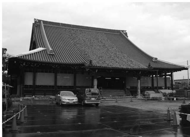
解体が終わり本堂が姿を現しました
