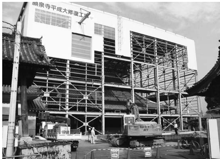
素屋根の外壁を取り外しています
