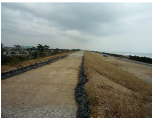
植栽工事前の防潮堤
