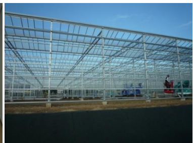
建設中の栽培ハウス
