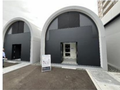
水素ガス圧縮機、冷凍機
