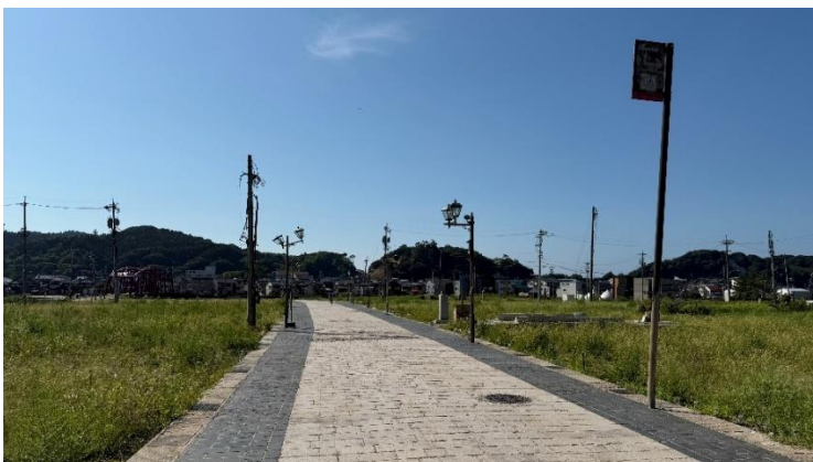
火災があった朝市付近の様子
