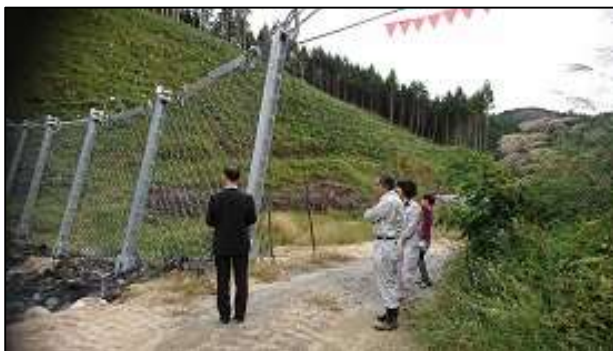
大雨により、上流から流れる岩石や流木を防御する強靭ワイヤネットが設置された現場
