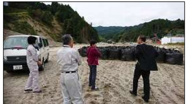
道路や家屋が、濁流による大量の土砂により堆積された現場を見学
