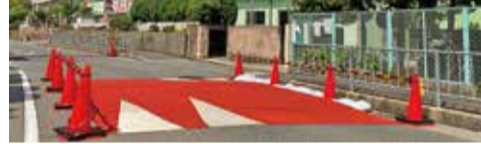
中央小学校前のハンプ(試験施工)
