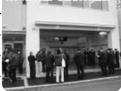
山手の防災拠点 消防署水間出張所
