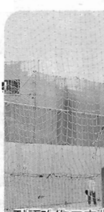
耐震改修工事中の西小学校
