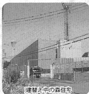
建替え中の森住宅
