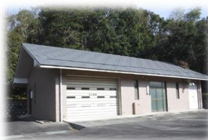
当配水場では、大阪広域水道企業団から受水\*し、東山給水区へ自然流下方式\*で配水しています。また、津田浄水場との連絡管で相互に送水し、自己水\*の有効利用と安定供給を図っています。平成13年度（2001年度）に配水池\*容量を7,500m<sup>3</sup>から12,000m<sup>3</sup>に増設しており、震災等の非常時の飲料水確保のための緊急遮断弁\*を設置しています。
