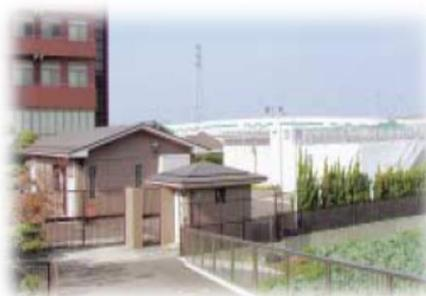
当受水場では、大阪広域水道企業団から受水し、三ヶ山配水場へポンプ圧送方式で送水しています。平成20年度（2008年度）に受水池容量を1,000m<sup>3</sup>から2,000m<sup>3</sup>に増設し、貯水能力を高めています。
