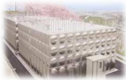
当配水場では、三ヶ山配水場より送られた水を貯水し、三ヶ山配水場より標高の高い三ヶ山山上給水区へ自然流下方式\*で配水しています。平成19年度（2007年度）に配水池\*容量を550m<sup>3</sup>から1,000m<sup>3</sup>に増設し、当該給水区における貯水能力を高めています。
