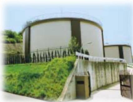
当配水場では、三ツ松受水場から送られた水を貯水し、地形を利用して自然流下方式で三ヶ山給水区へ配水しています。また、三ヶ山山上配水場へポンプ圧送方式で送水しています。平成15年度（2003年度）に配水池容量を3,000m<sup>3</sup>から6,000m<sup>3</sup>に増設しており、震災等の非常時の飲料水確保のための緊急遮断弁を設置しています。
