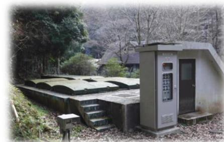
平成28年（2016年）4月から、当施設では蕎原中継ポンプ場から送られた水を自然流下方式で蕎原給水区に配水しています。現時点では、近木川の表流水\*を水源とし、緩速ろ過\*方式により浄水処理を行う自己水\*も併用しています。
