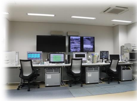
中央監視システム（津田浄水場）
