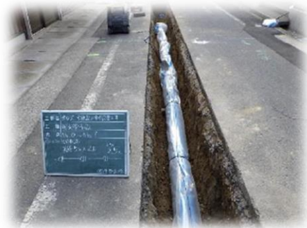
管路を更新する時には、耐震性に優れたダクタイル鋳鉄管を採用しています。
