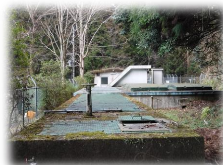
蕎原浄水施設
