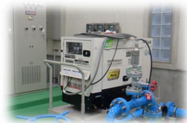
自家用発電設備
