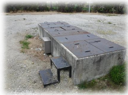
深井戸（津田浄水場）
