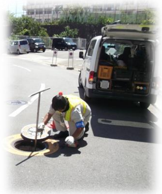
漏水調査の様子
