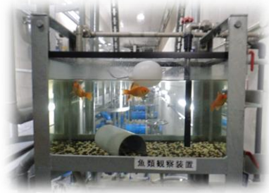
魚類観察装置による水質監視
