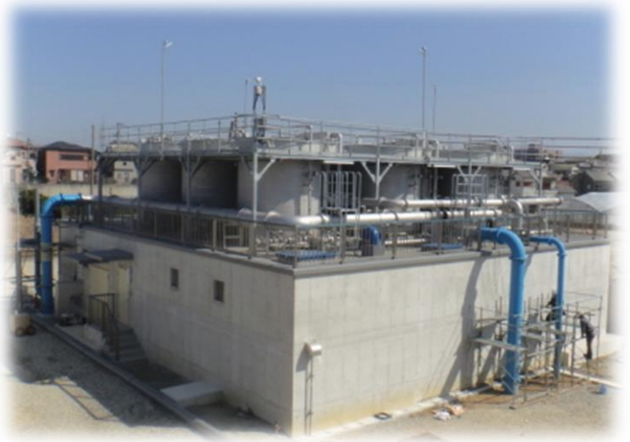
生物接触ろ過装置
