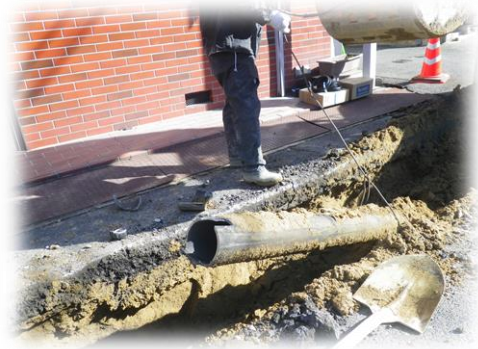
老朽管撤去の様子
