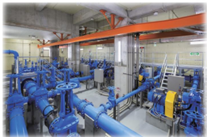
中央管理棟内のポンプ室
