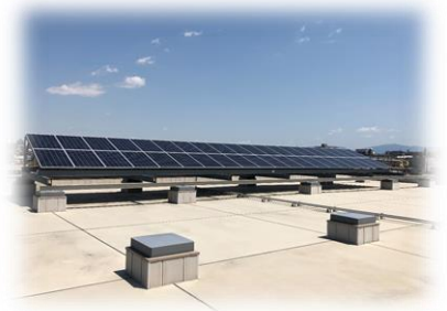
太陽光発電設備（津田浄水場）
