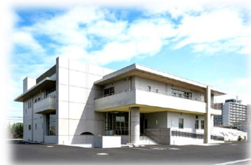
津田浄水場 中央管理棟
