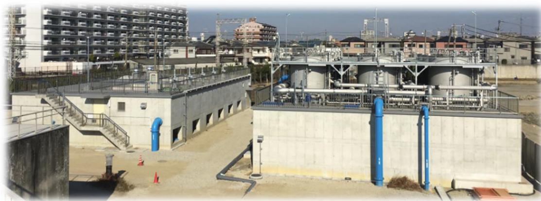
津田浄水場 急速ろ過池(左)と生物接触ろ過施設(右)
