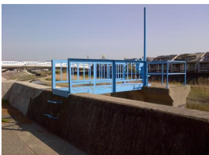
③⑰ 樋門27(近木川)
