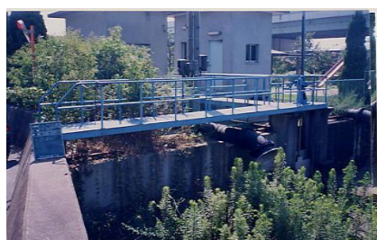
②⑨ 樋門3-2(阪南3区)
