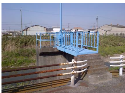
③⑯ 樋門26(近木川)
