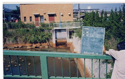
③⑩ 樋門5-2(西町)
