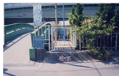
③⑪ 樋門5-3(西町)
