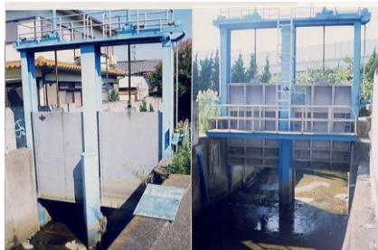
③⑫ 樋門6(難波川)
