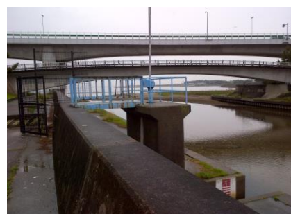
③⑱ 樋門28(近木川)
