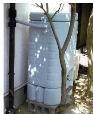
雨水貯留施設
