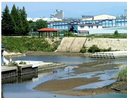
自然再生が進む近木川汽水ワンド
