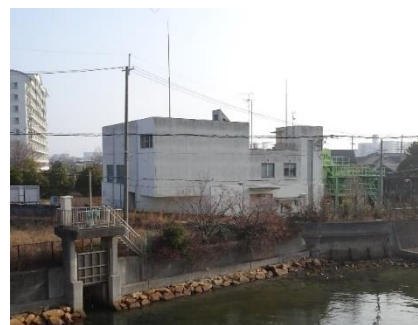
既存施設の適切な維持管理（津田雨水ポンプ場）
