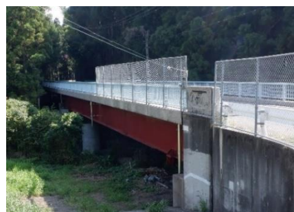
耐震補強工事(新蕎原大橋)
