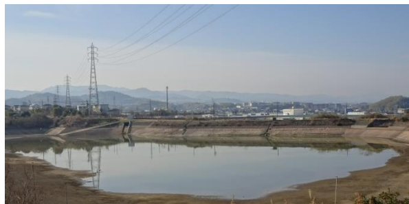
流出抑制機能を持つ森大池
