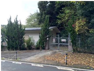
名称 木積中継ポンプ場 建築年月日 2006/03/01 建築延床面積 29.42 m 2
