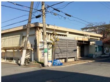
名称 東共同浴場 建築年月日 1967/04/01 建築延床面積 371.50 m 2
