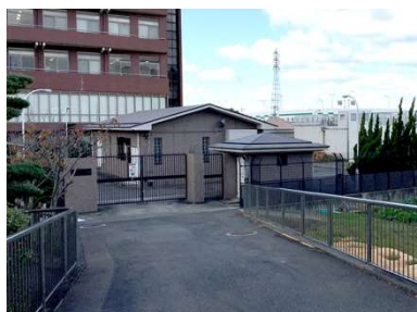
名称 三ツ松受水場 建築年月日 1999/03/01 建築延床面積 235.70 m 2
