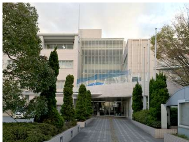
名称 保健福祉合同庁舎 建築年月日 1995/10/25 建築延床面積 3,570.97 m 2
