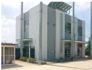
名称 東山小学校仲よしホーム 建築年月日 2010/01/01 建築延床面積 443.30 m 2
