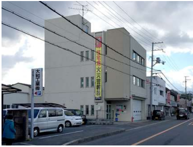
名称 消防署 水間出張所 建築年月日 2009/01/29 建築延床面積 323.85 m 2
