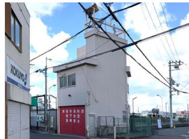
名称 第7分団器具庫 建築年月日 1979/06/01 建築延床面積 64.17 m 2
