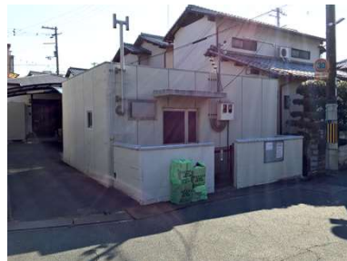
名称 清名台第二マンホールポンプ場 建築年月日 1975/10/01 建築延床面積 50.19 m 2
