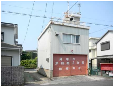
名称 第2分団器具庫 建築年月日 1974/05/01 建築延床面積 80.00 m 2
