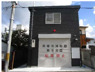
名称 第9分団器具庫 建築年月日 2022/10/25 建築延床面積 77.60 m 2
