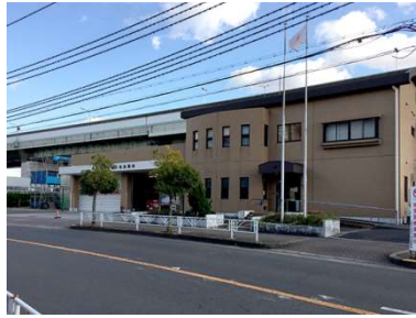
名称 消防署 二色出張所 建築年月日 1990/12/26 建築延床面積 641.22 m 2
