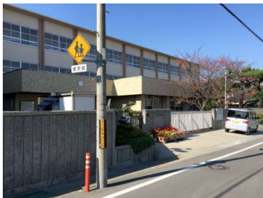
名称 木島小学校 建築年月日 1982/03/01 建築延床面積 5,827.29 m 2
