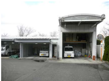
名称 市役所ストックヤード 建築年月日 2012/03/01 建築延床面積 27.84 m 2
