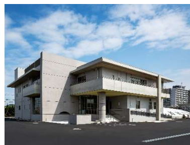
名称 津田浄水場 建築年月日 2016/06/30 建築延床面積 3,979.54 m 2
