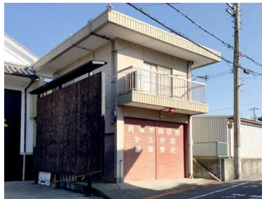
名称 第3分団器具庫 建築年月日 1971/09/01 建築延床面積 53.35 m 2
