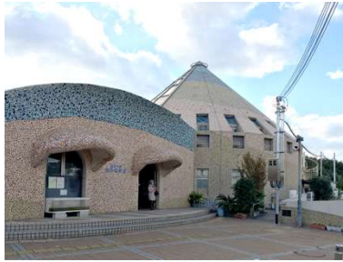
名称 自然遊学館 建築年月日 1993/09/01 建築延床面積 627.71㎡
