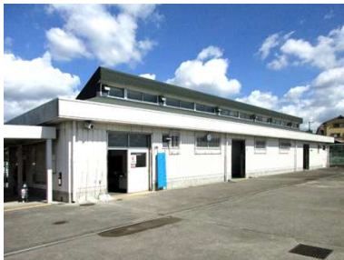
名称 旧第4プール 建築年月日 1987/06/01 建築延床面積 251.61 m 2
