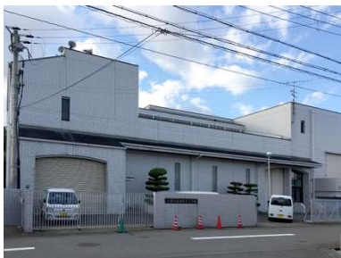
名称 二色の浜雨水ポンプ場 建築年月日 1992/04/01 建築延床面積 2,432.59 m 2
