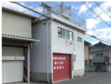
名称 第6分団器具庫 建築年月日 1976/09/01 建築延床面積 103.00 m 2
