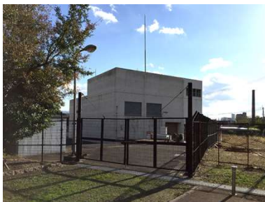
名称 津田雨水ポンプ場 建築年月日 1990/11/11 建築延床面積 1,030.82 m 2
