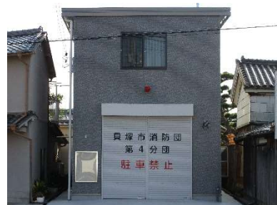
名称 第4分団器具庫 建築年月日 2021/10/26 建築延床面積 87.20 m 2
