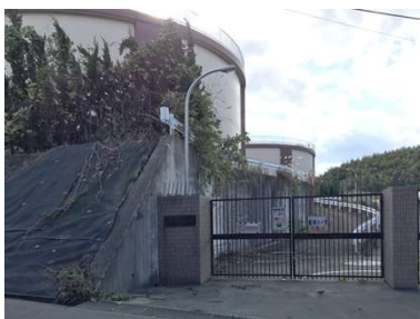
名称 三ヶ山配水場 建築年月日 1999/03/01 建築延床面積 138.58 m 2
