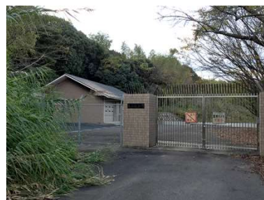
名称 東山配水場 建築年月日 2003/03/01 建築延床面積 127.46 m 2
