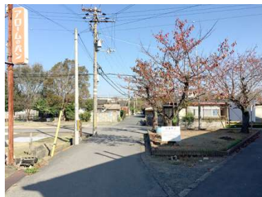
名称 第2橋本住宅 建築年月日 1961/04/01 建築延床面積 6,852.76 m 2
