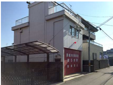
名称 第5分団器具庫 建築年月日 1976/01/01 建築延床面積 80.00 m 2
