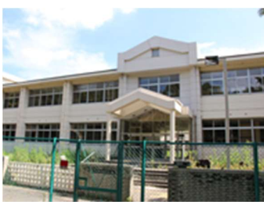
名称 旧貝塚養護学校 建築年月日 1959/11/01~1989/10/01 建築延床面積 5,690.61 m 2
