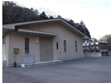
名称 蕎原中継ポンプ場 建築年月日 2015/07/01 建築延床面積 66.90 m 2
