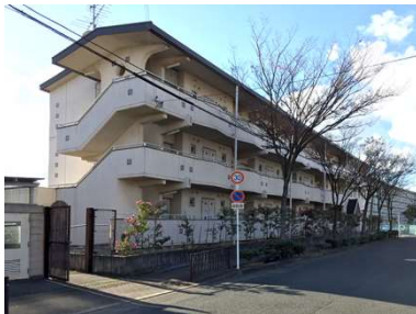
名称 職員宿舎 建築年月日 1994/03/24 建築延床面積 771.52 m 2
