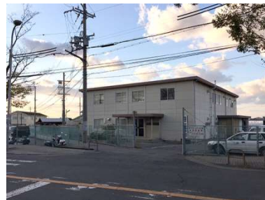
名称 市役所分室（書庫・文化財分室） 建築年月日 1994/05/01 建築延床面積 597.96 m 2
