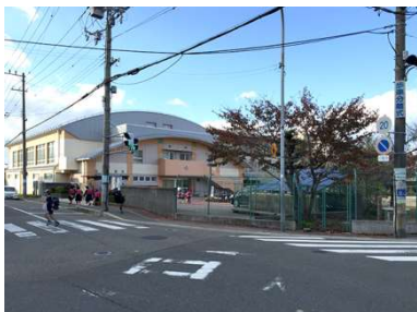
名称 西小学校 建築年月日 1981/03/01 建築延床面積 7,091.17 m 2
