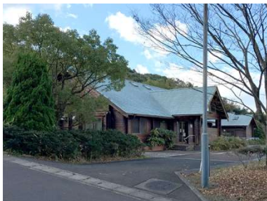
名称 公園墓地管理棟 建築年月日 1993/03/01 建築延床面積 163.48 m 2
