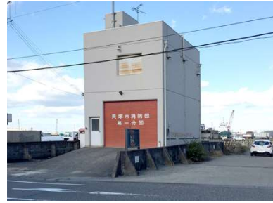
名称 第1分団器具庫 建築年月日 1975/09/01 建築延床面積 84.00 m 2
