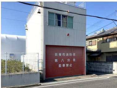
名称 第8分団器具庫 建築年月日 1977/03/01 建築延床面積 67.80 m 2
