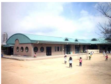
名称 西幼稚園 建築年月日 2001/01/01 建築延床面積 708.83 ㎡
