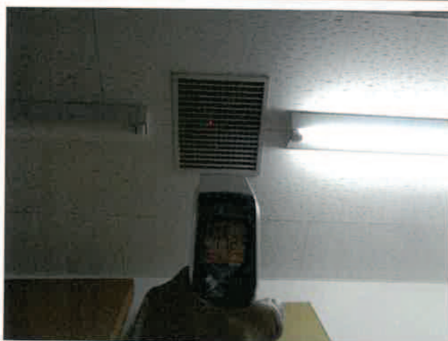
空調設備機器点検
