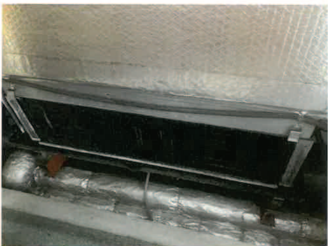
ファンコイル点検 運転状態確認
