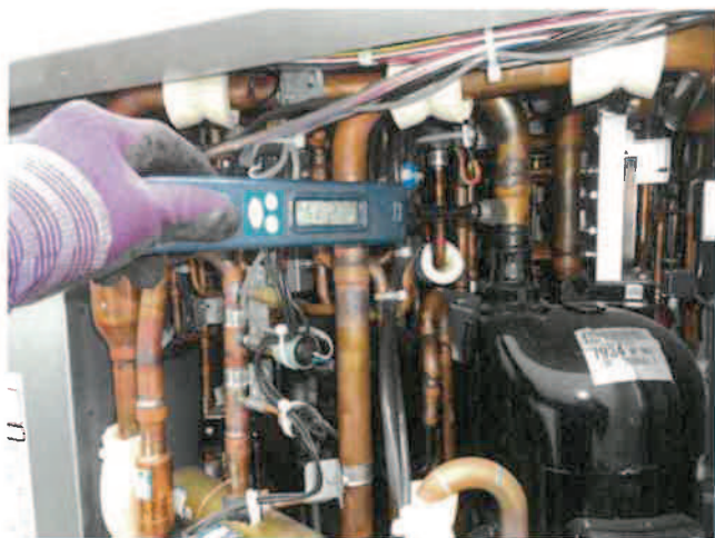
チラー点検 吸入管温度測定
