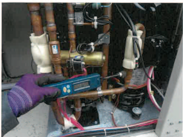
チラー点検 吐出管温度測定
