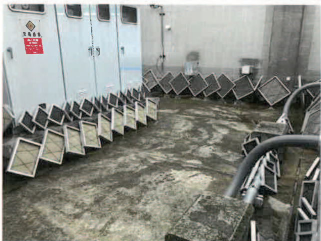
空調設備機器点検 エアーフィルター 清掃後
