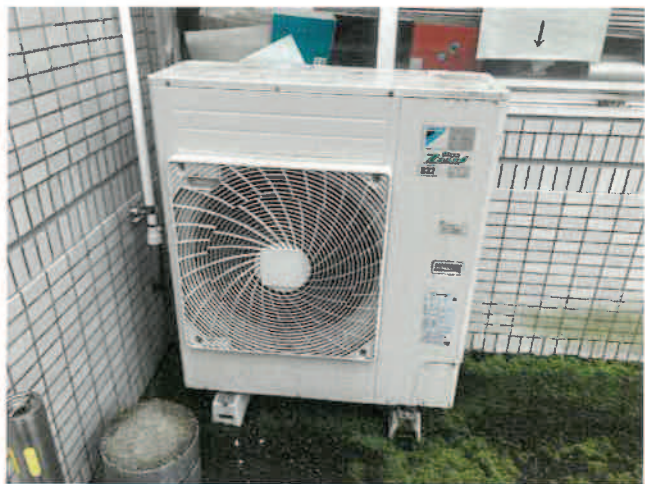
エアコン点検 室外機点検
