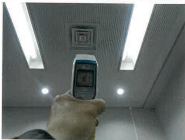
空調設備機器点検
