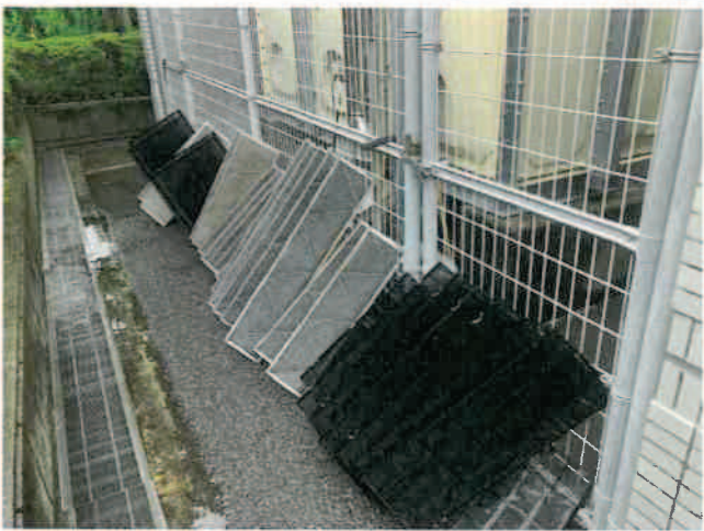
各空調機フィルター清掃 作業後
