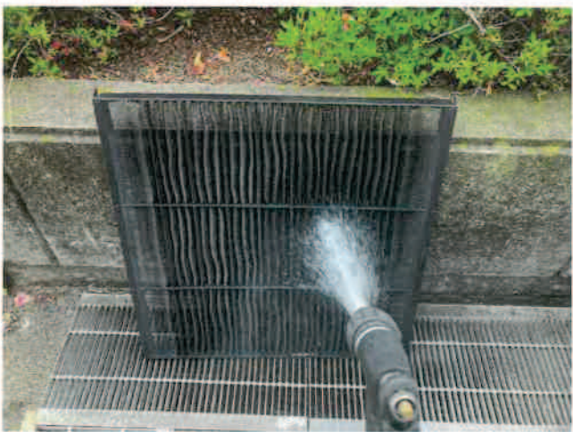
各空調機フィルター清掃 作業中
