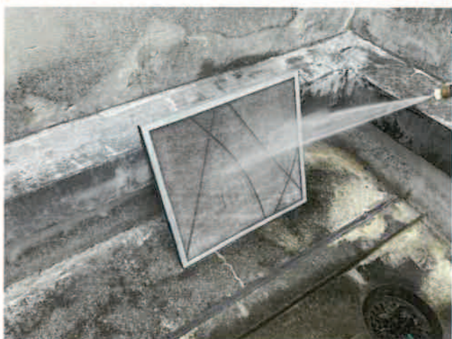
空調設備機器点検 エアーフィルター 清掃中
