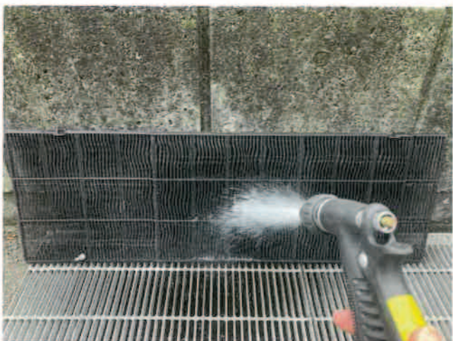
各空調機フィルター清掃 作業中
