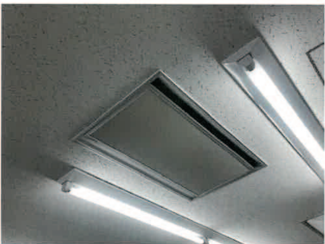
全熱交換器 外観点検
