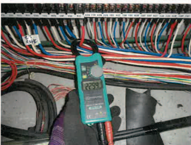
空気調和機点検 電流値測定
