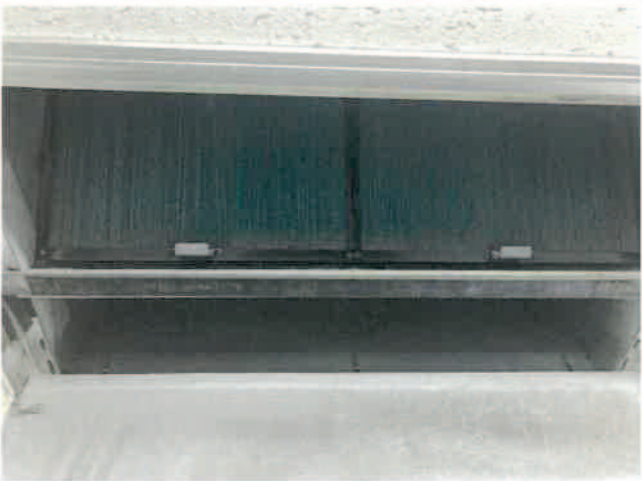
全熱交換器 内部点検
